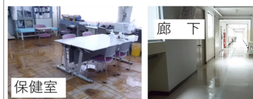
佐屋小学校の浸水
