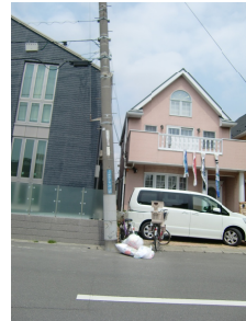
(写真は浦安市の傾いた住宅)
